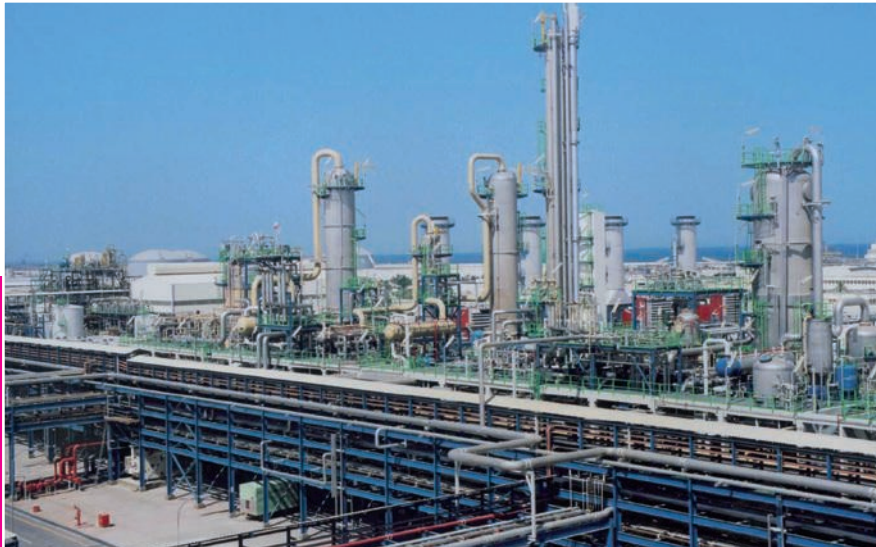
VCM-Anlage mit VinTec-Lizenz in Qatar 2001
